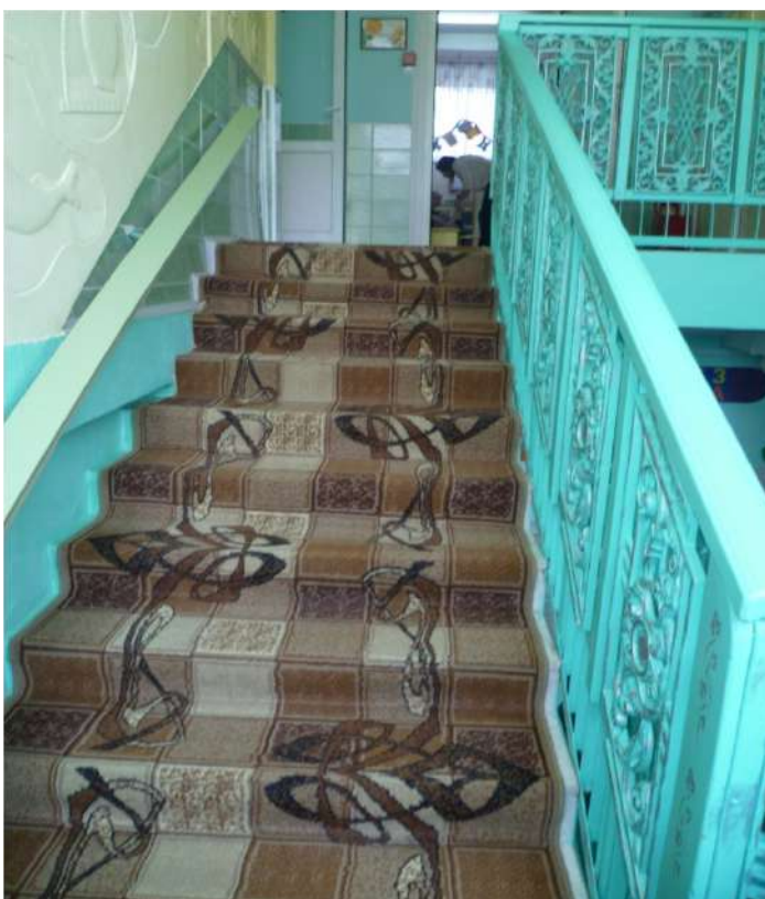
Фото №20. Лестница (внутри здания)
