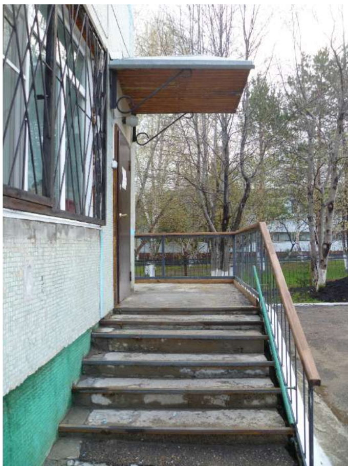
Фото №11. Лестница (наружная)
