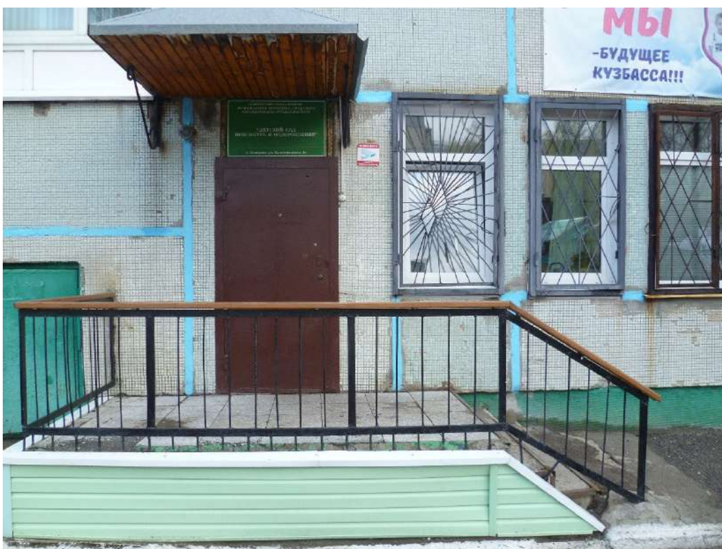
Фото №12. Входная площадка перед дверью
