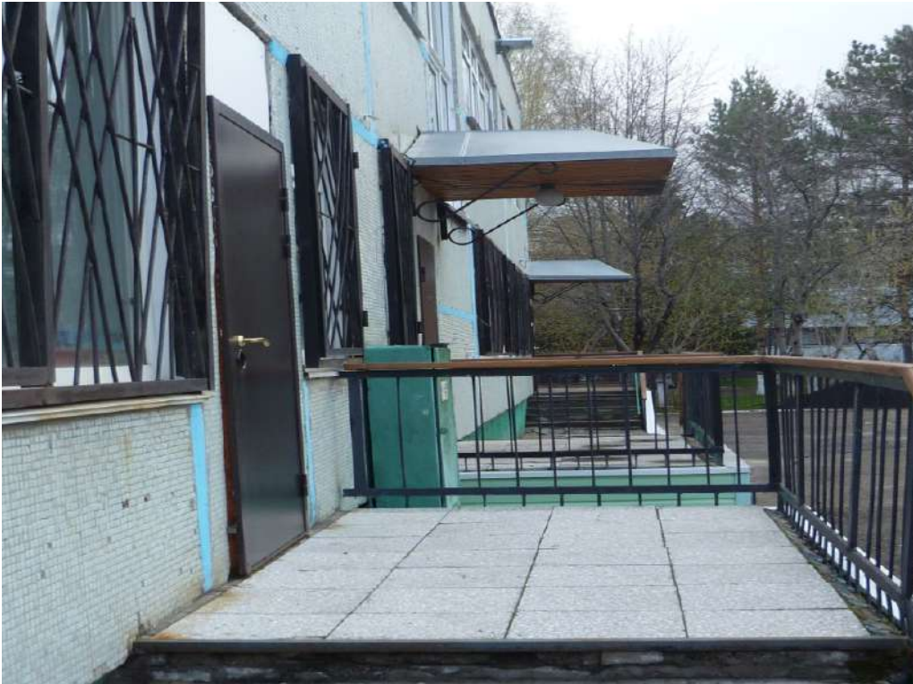
Фото №13. Дверь (входная)
